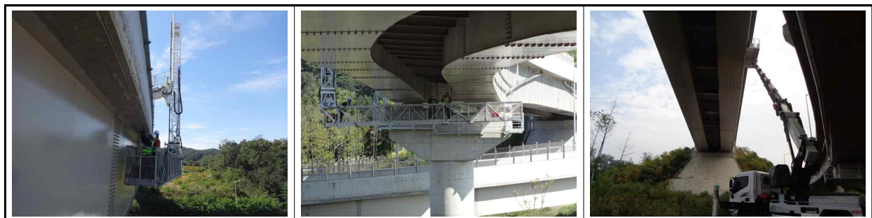
[고소작업차, 굴절점검차를 이용한 근접조사 실시]
