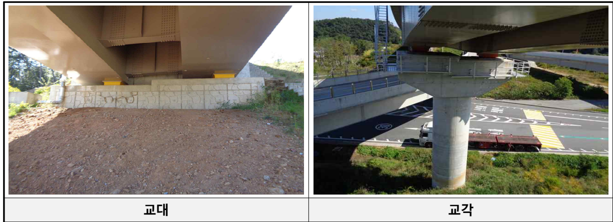
[교대 및 교각 전경]
